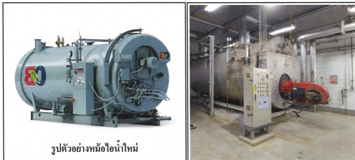
หม้อไอน้ำใหม่ ขนาด 8 ตัน/ชั่วโมง หม้อไอน้ำหลัก
