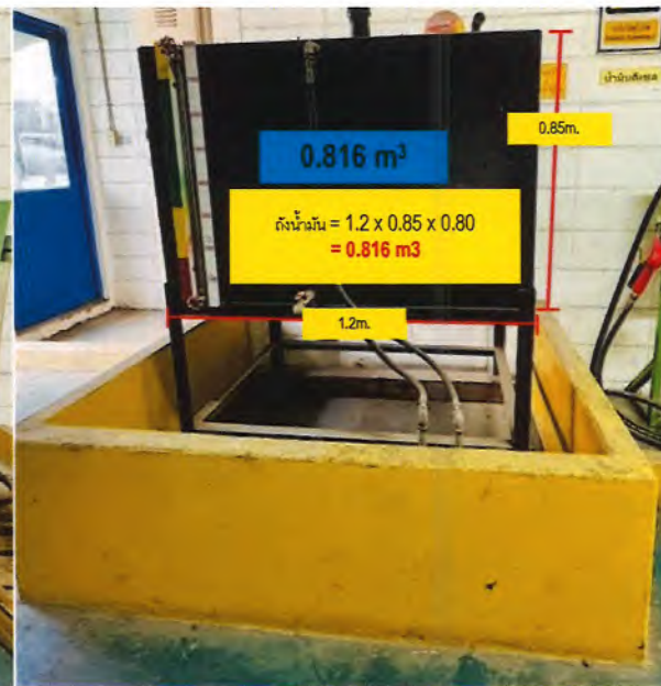
รูปที่ 2.3.3-4 การจัดเก็บน้ำมันดีเซลสำหรับเดินเครื่องกำเนิดไฟฟ้าสำรอง (Emergency Generator)
