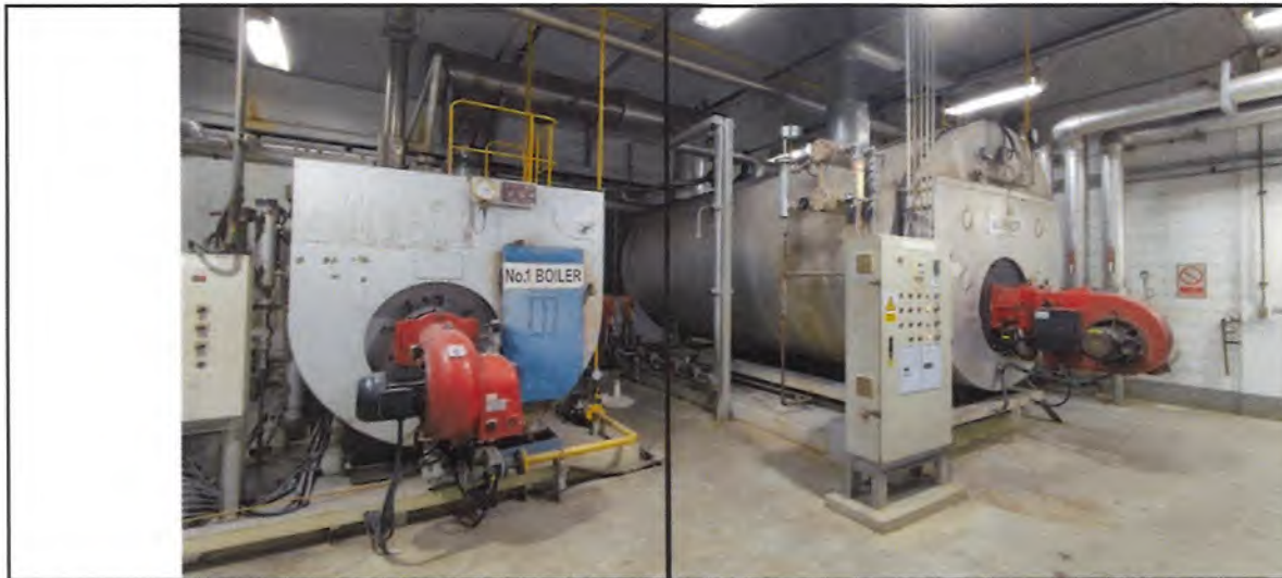
หม้อไอน้ำ ขนาด 2.5 ตัน/ชั่วโมง หม้อไอน้ำสำรอง
